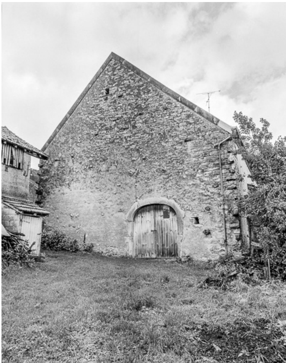
Façade latérale droite.
