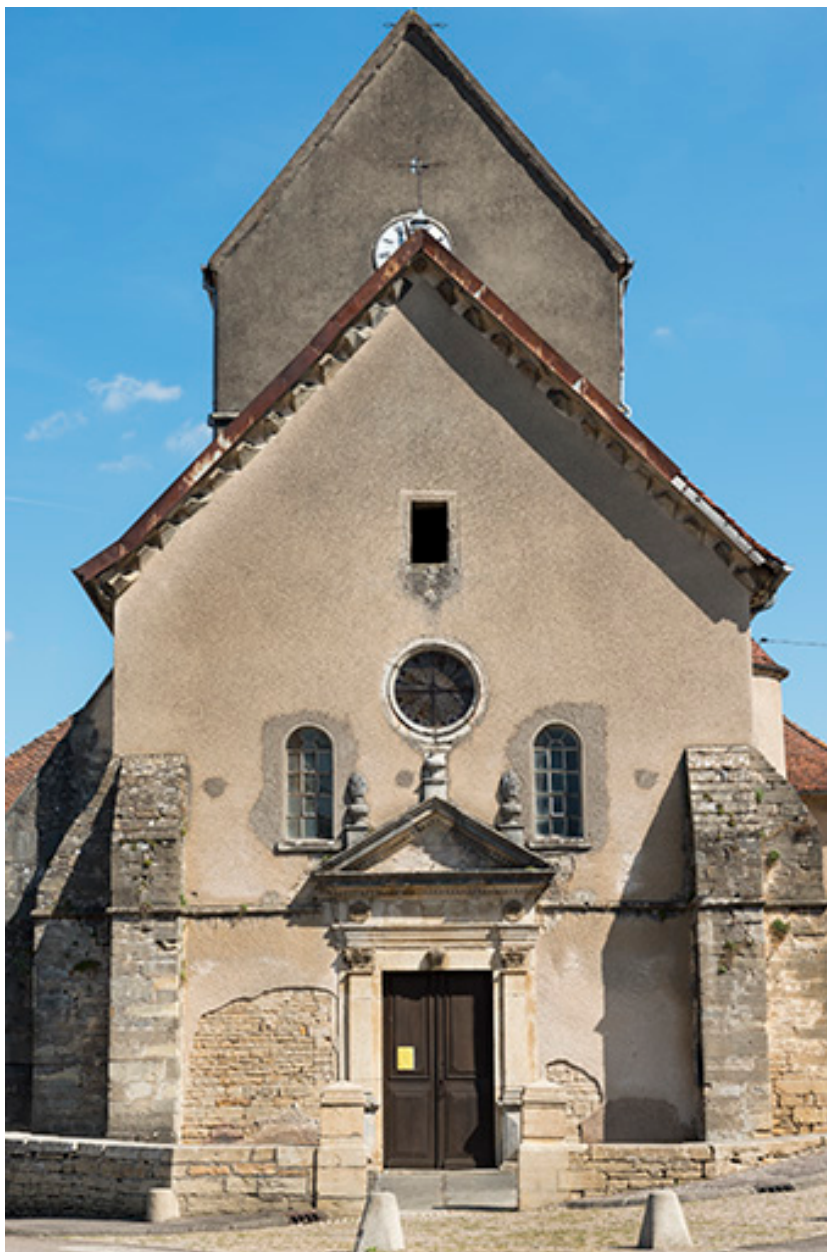
Vue avant restauration (2016).
