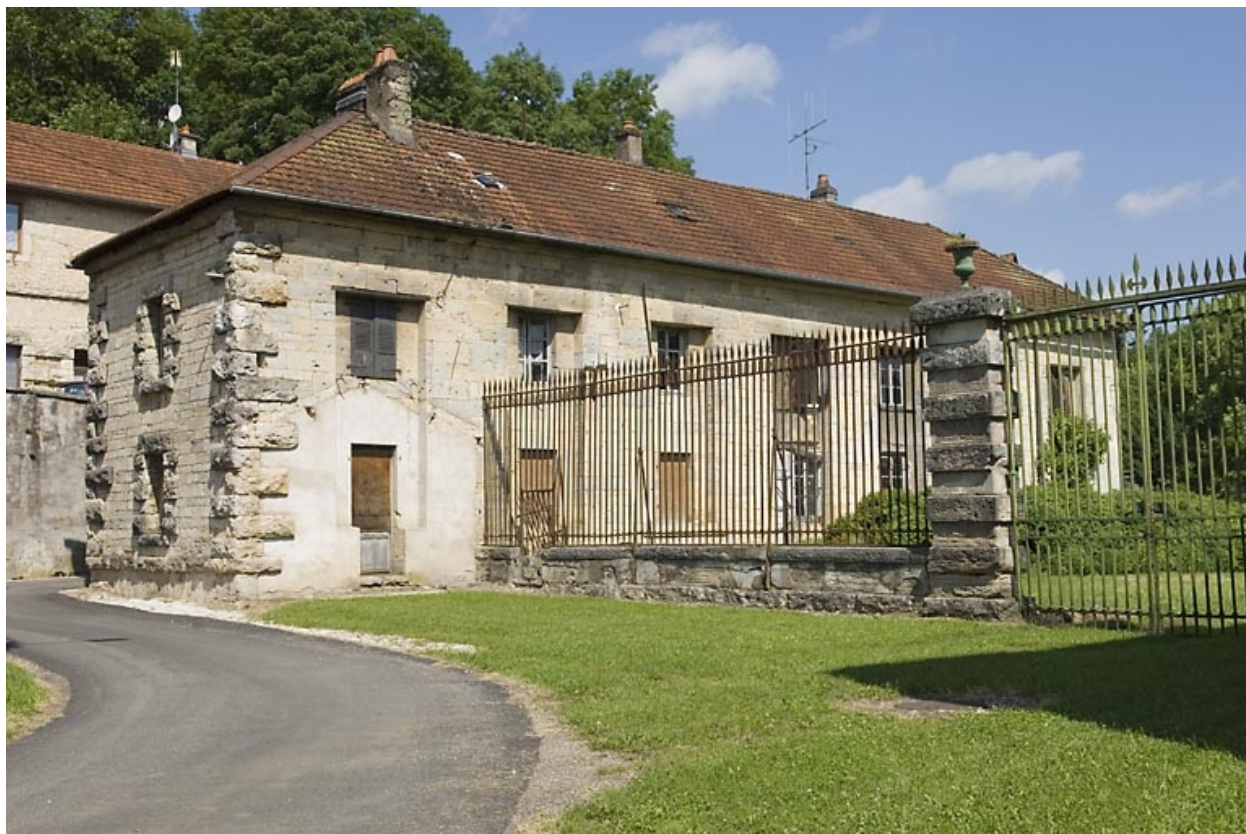
Logement (ancienne orangerie) vu depuis la cour.
