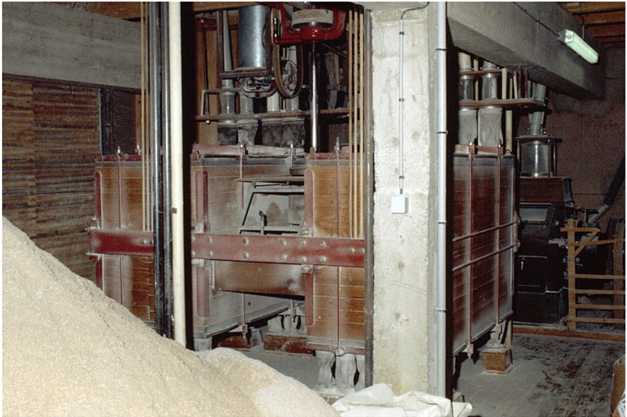
Minoterie (H), rez-de-chaussée : plansichter.
