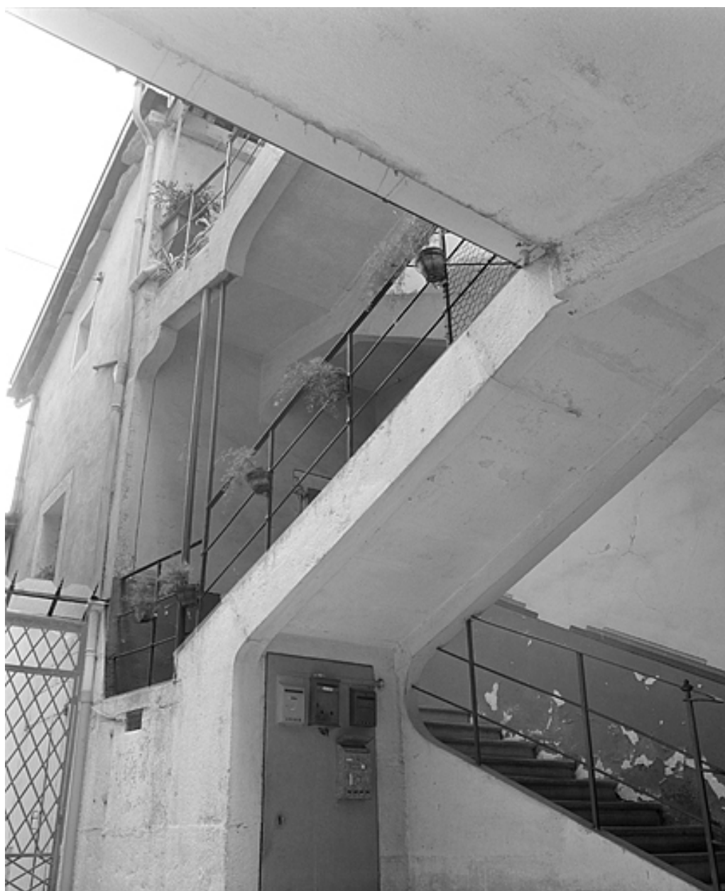
L'escalier ouvrant sur la cour.
