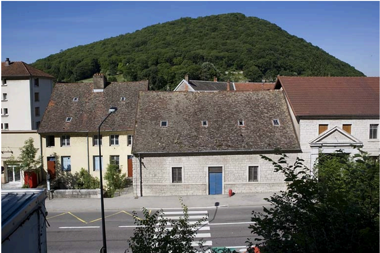
Façade antérieure des logements désaffectés et de la remise.
