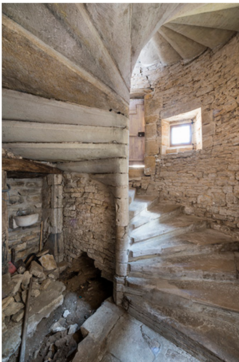
L'escalier, vue depuis le rez-de-chaussée.
