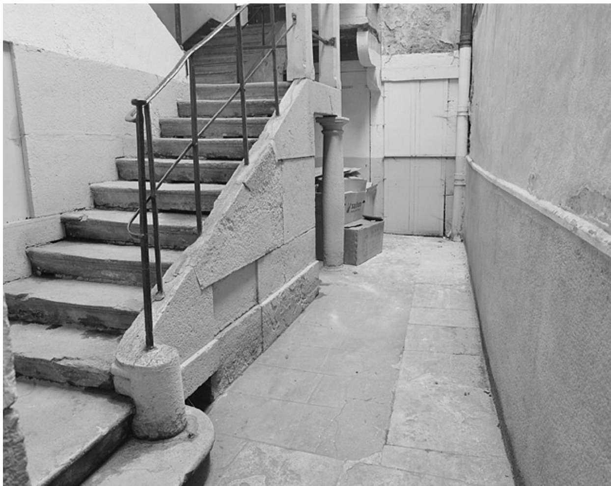
Maison, 26 rue du Commerce, escalier sur cour.
