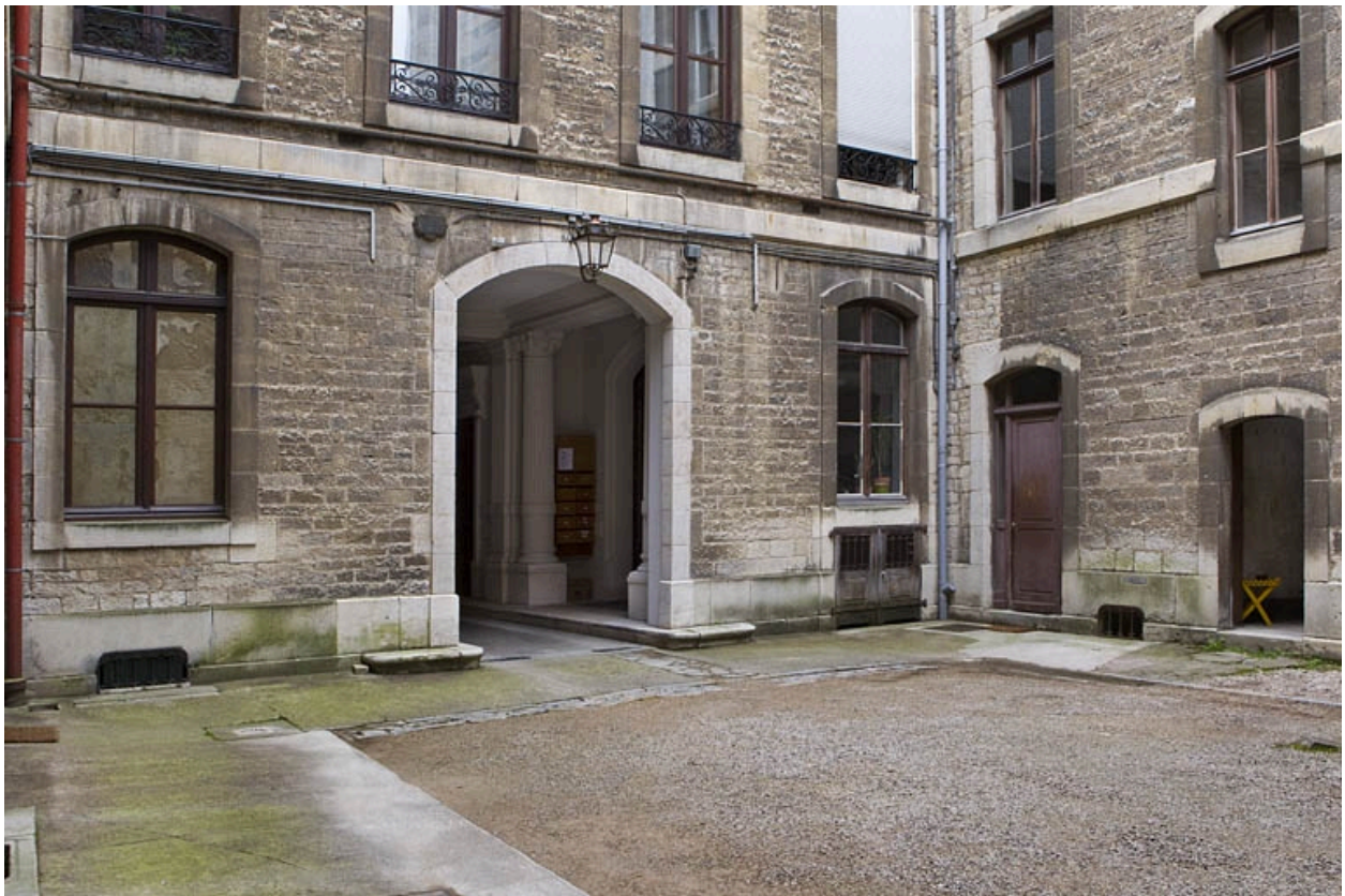
Façade postérieure sur cour : détail du rez-de-chaussée de trois quarts gauche.
