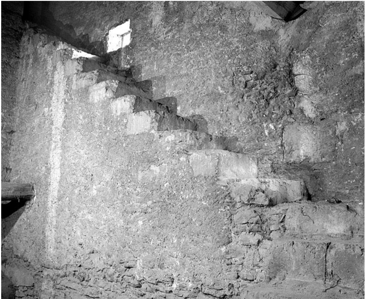
Escalier dans les combles à l'extrémité du collatéral sud.
