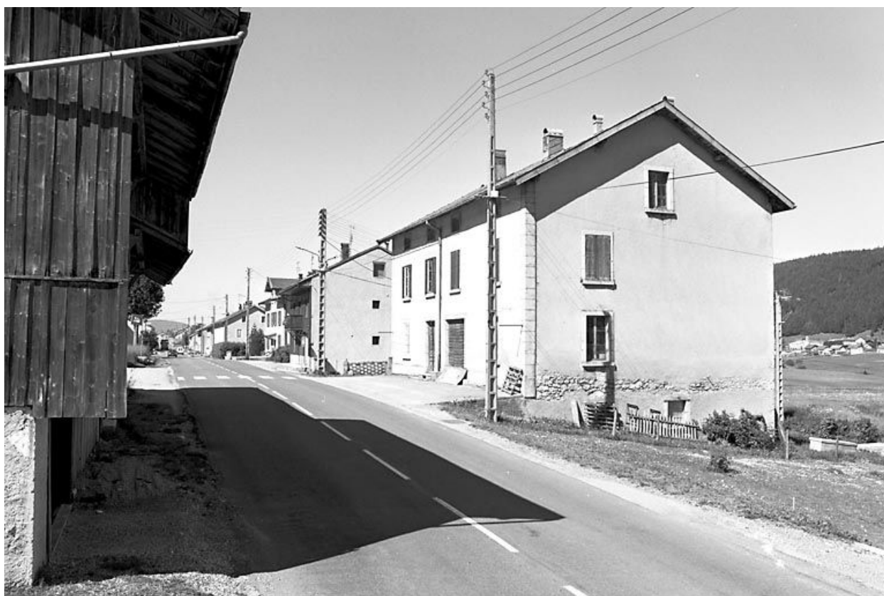
Ferme située au lieudit Les Meuniers.
