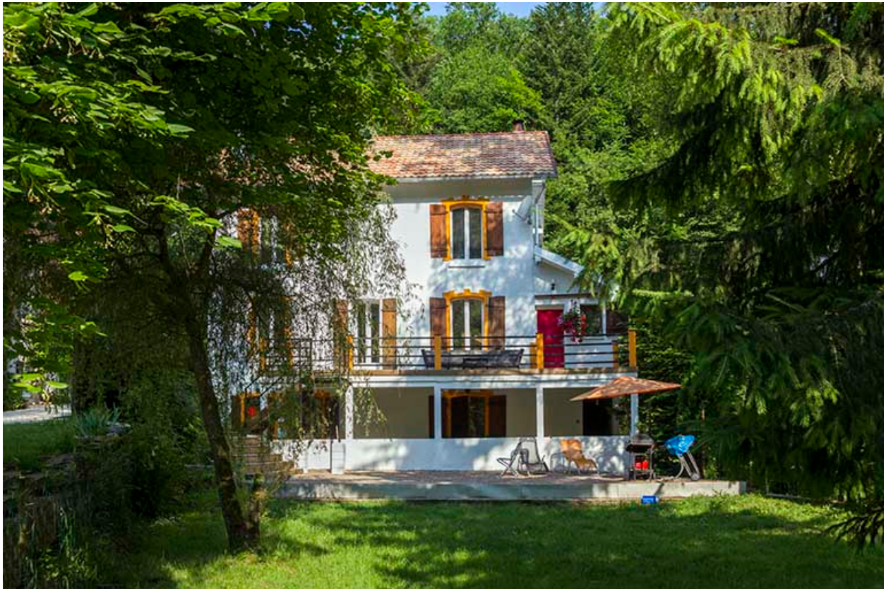
Logement de contremaître : façade postérieure.
