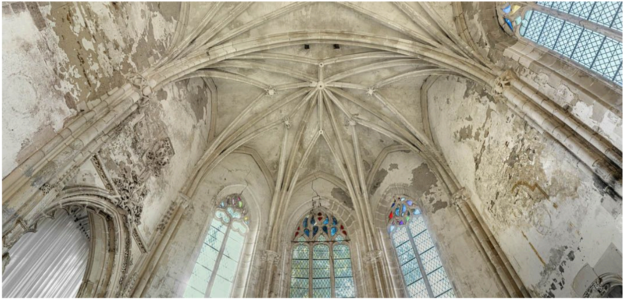
Intérieur de la chapelle : voûtes du choeur.
