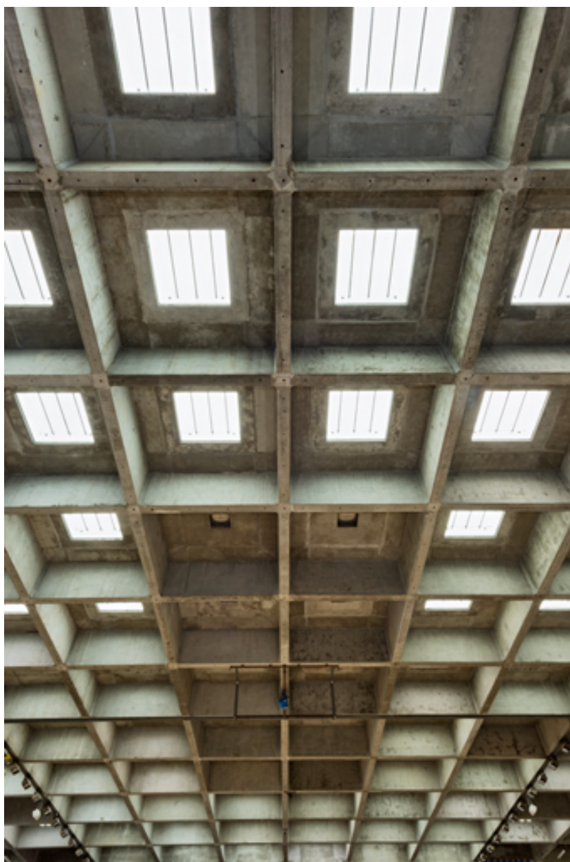
Maison des sports, grand gymnase : plafond.
