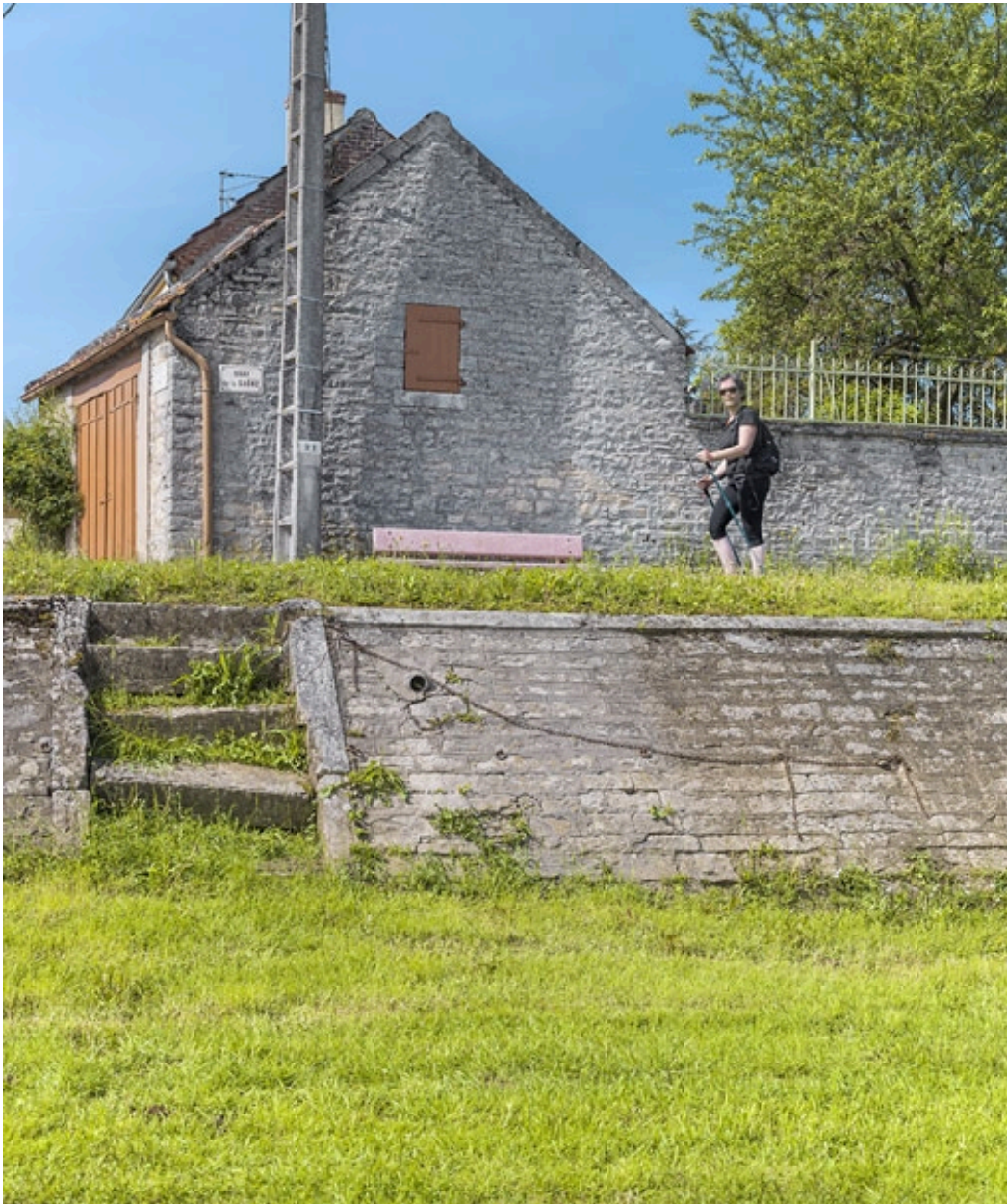
Escalier de sauvetage.
