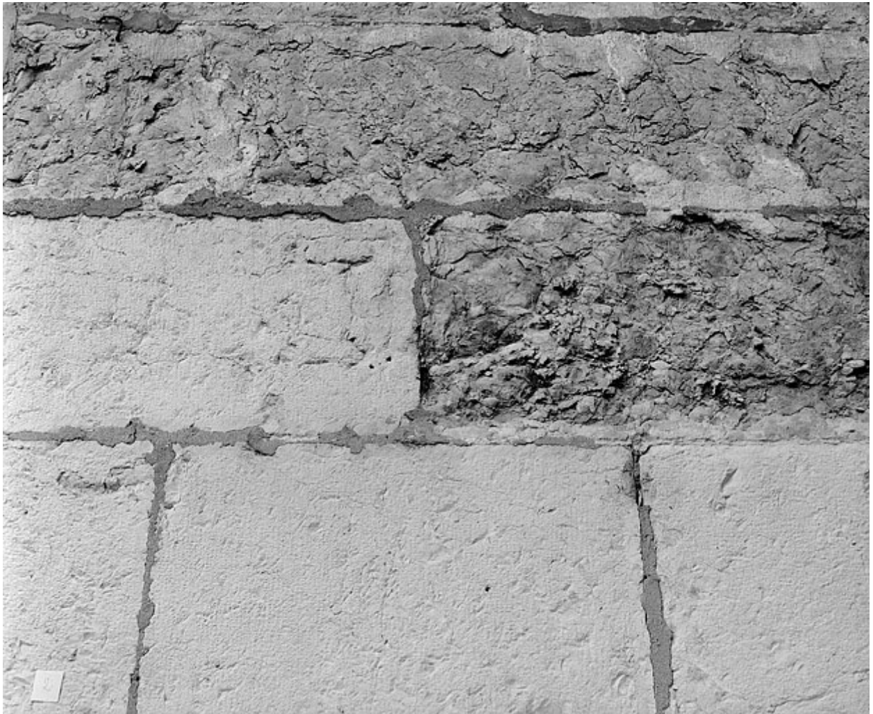
Détail du parement du contrefort à l'extrémité orientale du collatéral nord.
