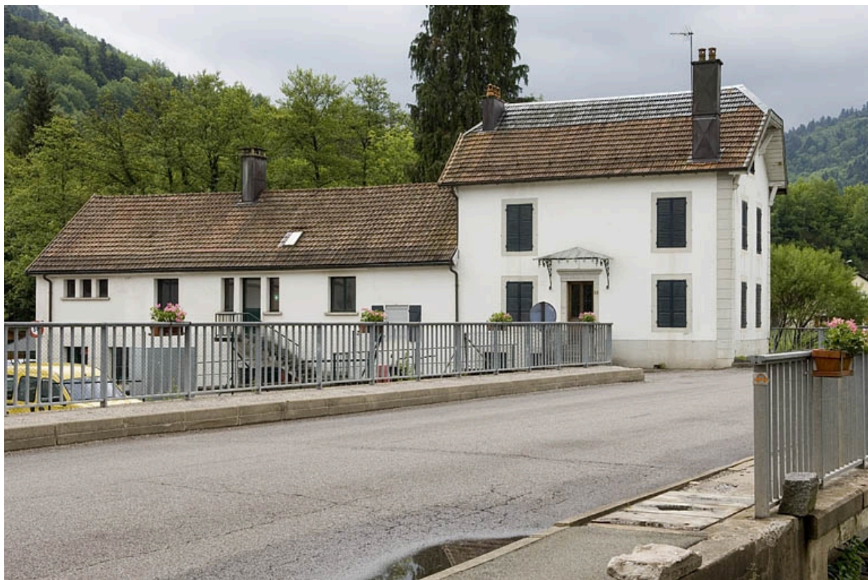
Le bâtiment de l'ancien moulin.
