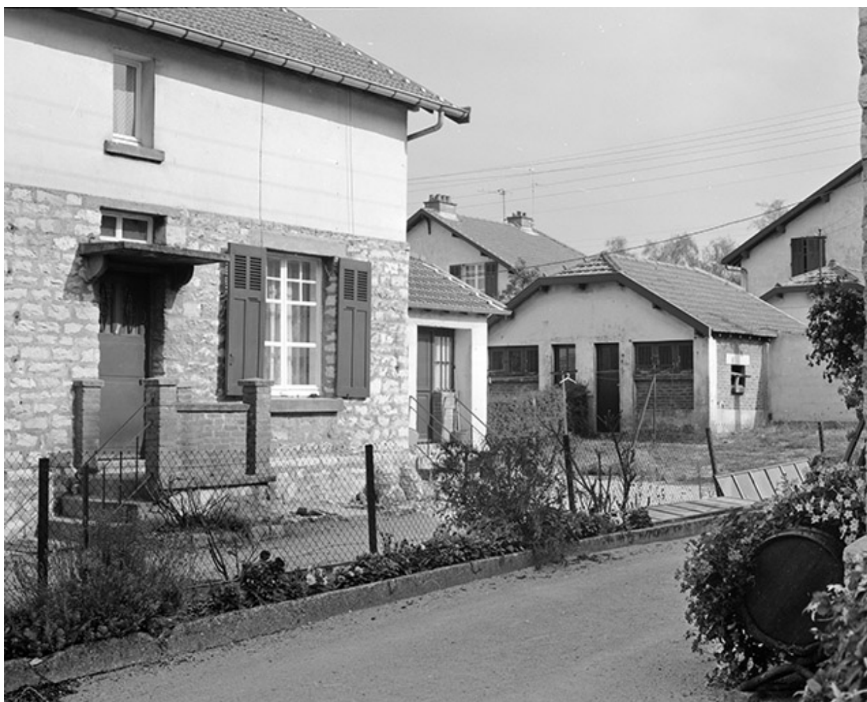
Maison identique, 26, 28 rue de Lorraine, la remise.
