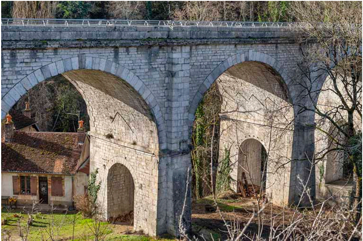
Vue sur les arches, depuis le nord-est.
