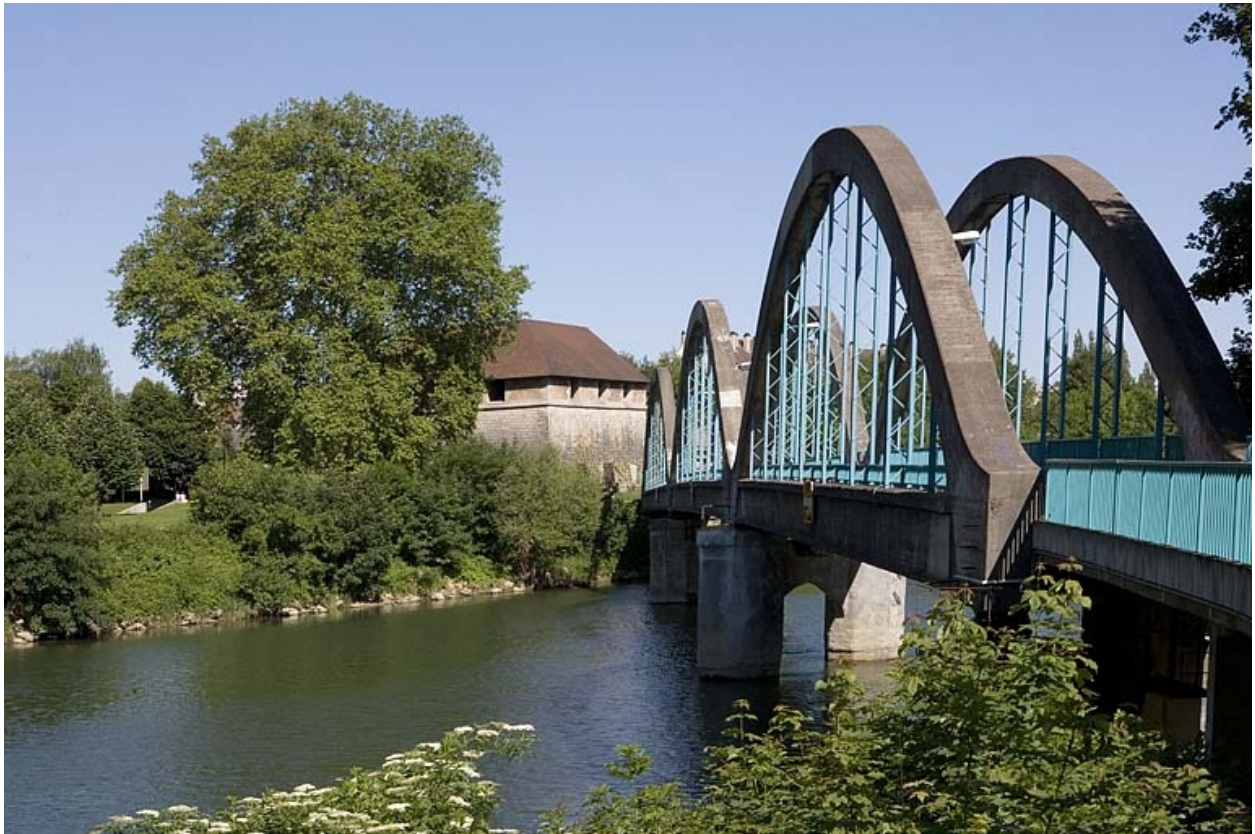
Face amont depuis la rive droite.
