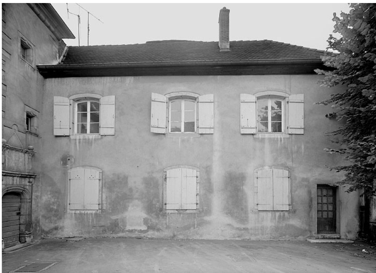
Aile droite. Façade sur la cour.
