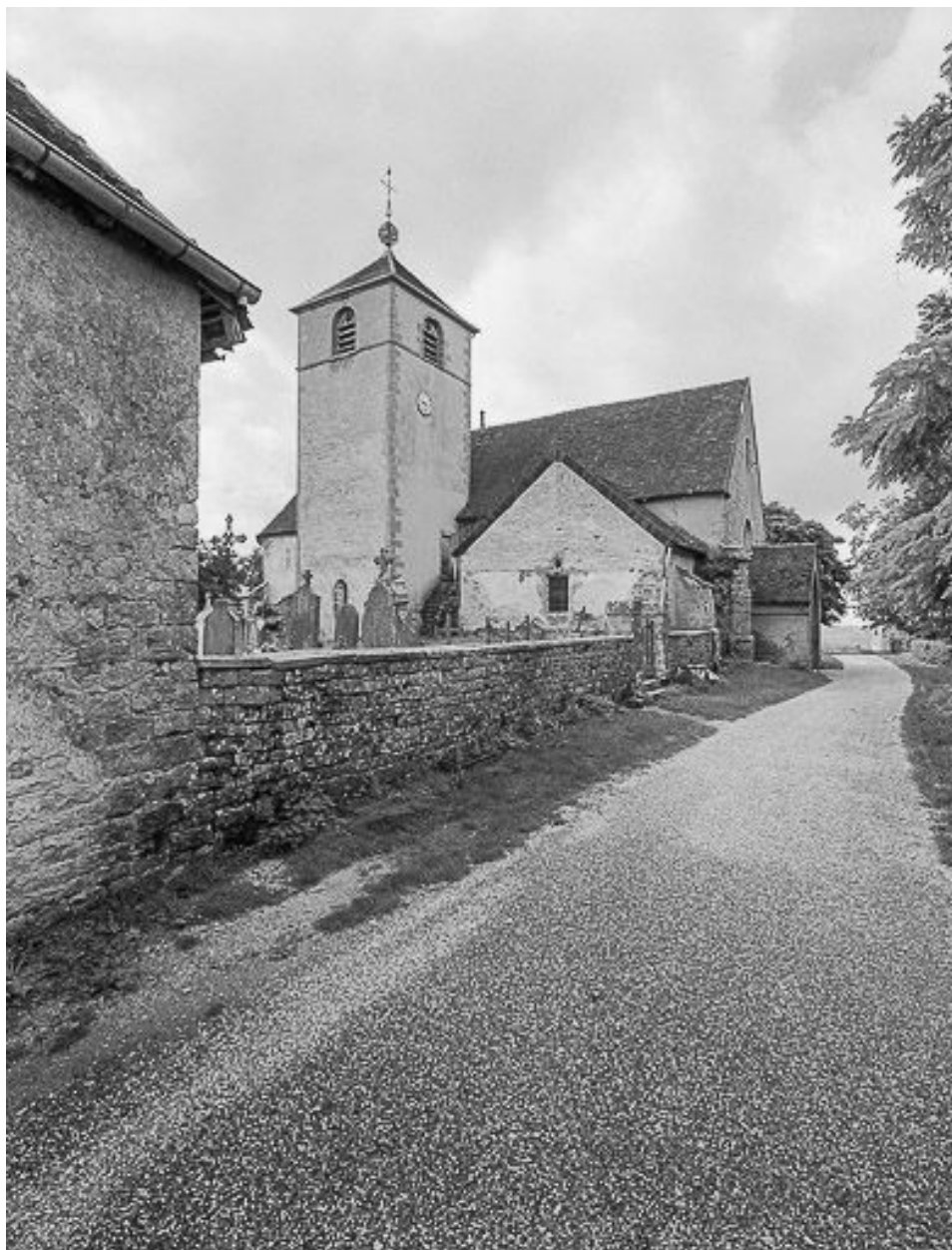
Façade latérale gauche, vue de l'ouest.
