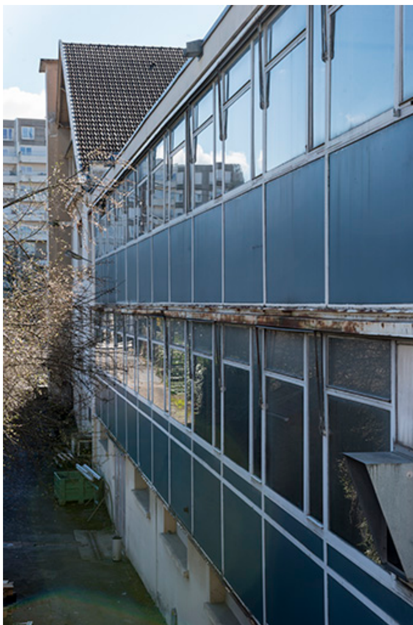
Façade orientale de l'extension nord.
