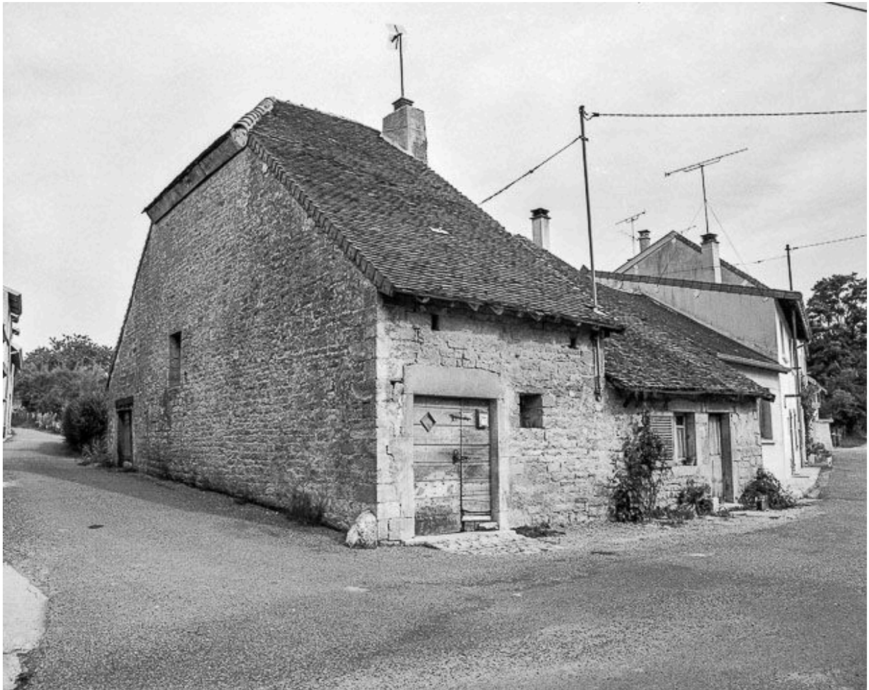
Façades antérieure et latérale gauche.
