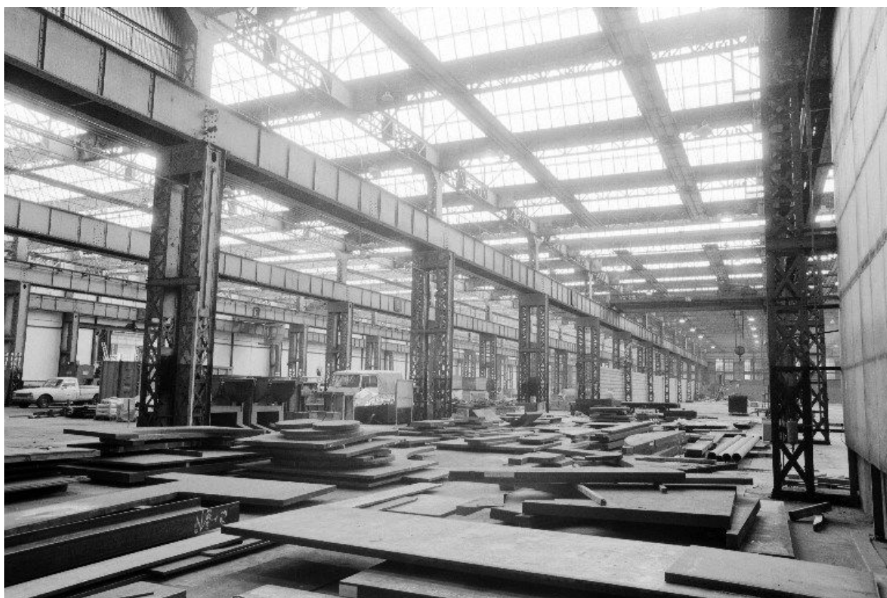
Les ateliers construits entre 1914 et 1917, couverts de sheds.
