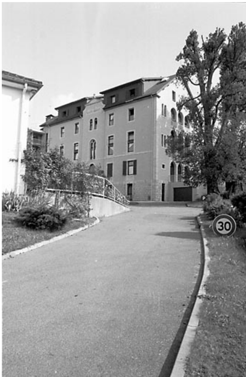
Façades antérieure et latérale droite.
