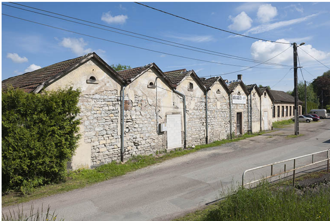
Murs-pignons de l'atelier de filature.
