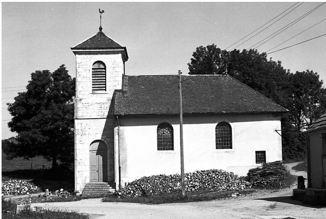
Vue de la façade latérale droite.
