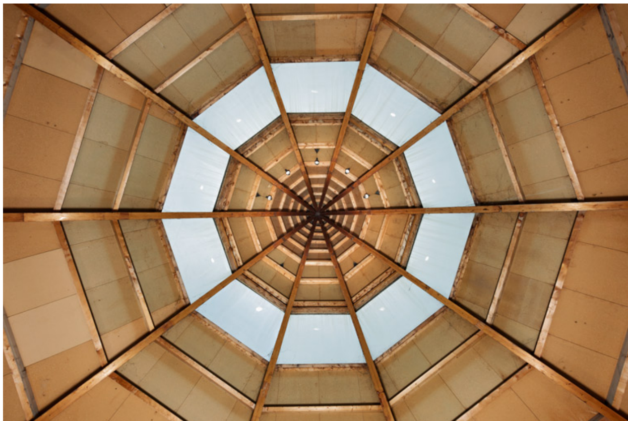
Lanternon. Vue en contre-plongée.
