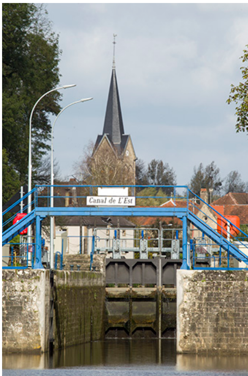
Vue rapprochée de l'écluse vue de l'aval.
