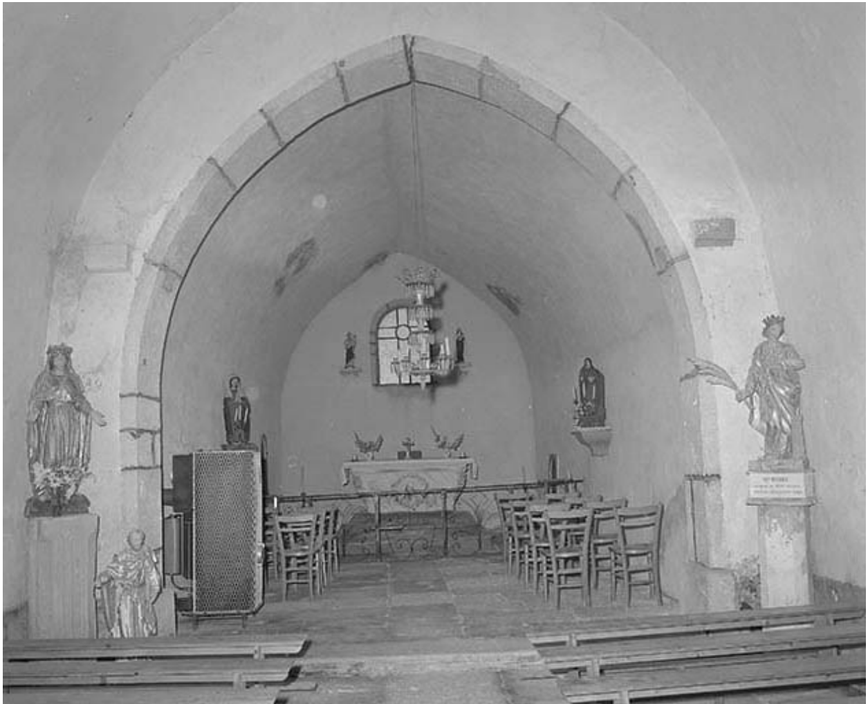
Intérieur : le chœur vu depuis la nef.
