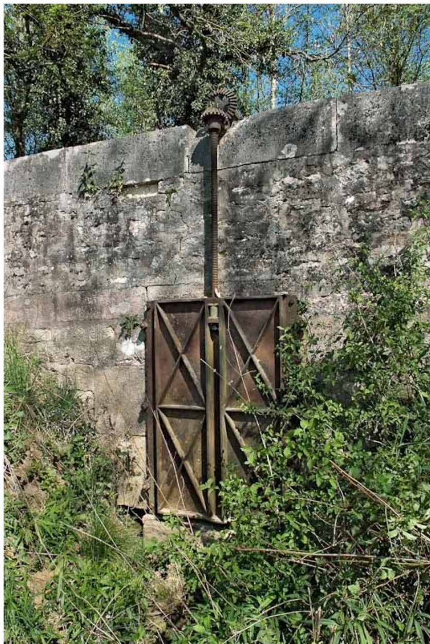
Vanne de l'aqueduc ménagé dans la route-digue.
