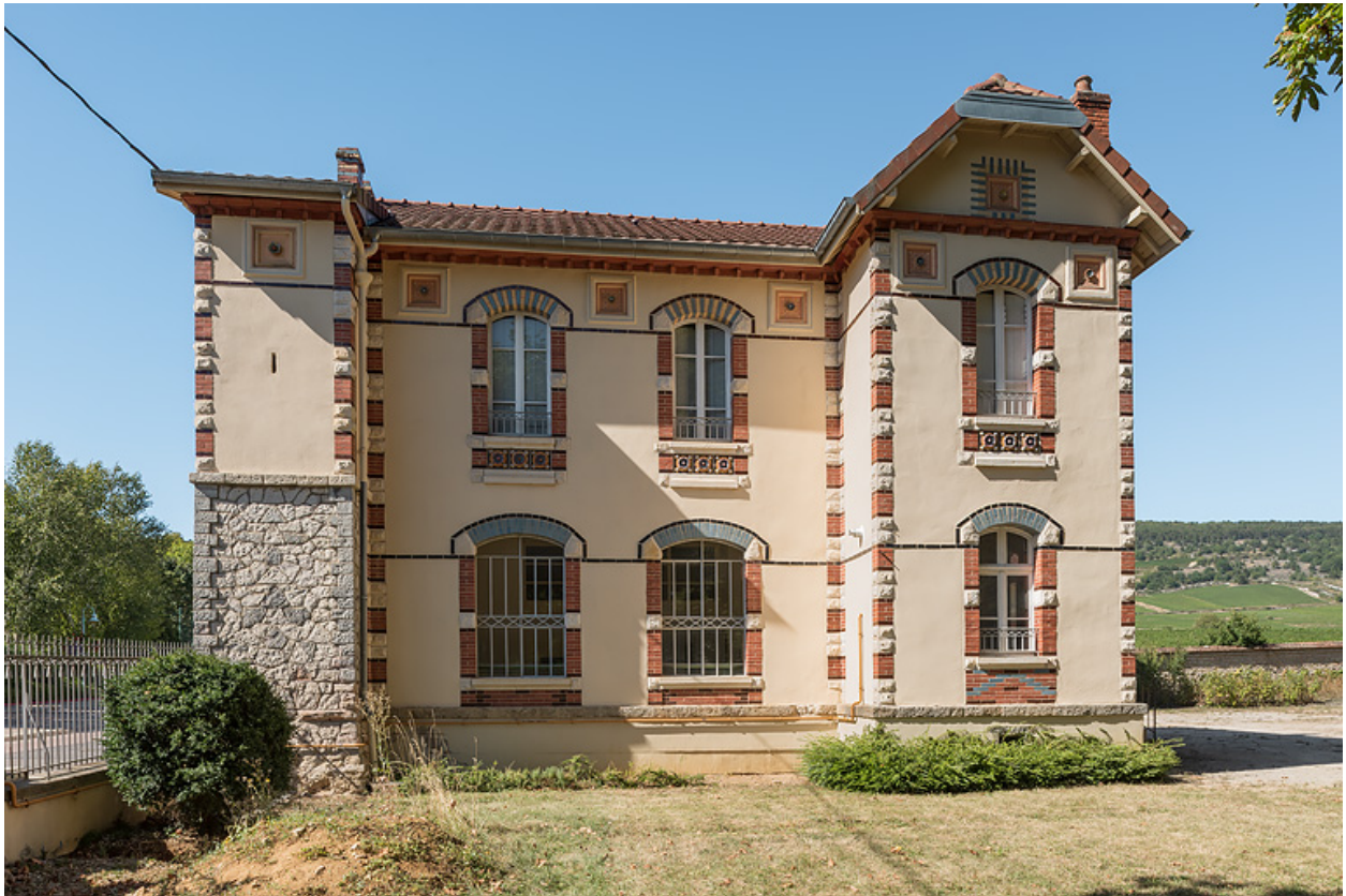
Bâtiment du forage avec logement du gardien à l'étage, façade principale.
