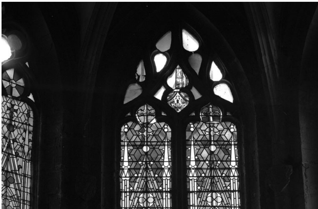
Baie 0 : vue d'ensemble.
