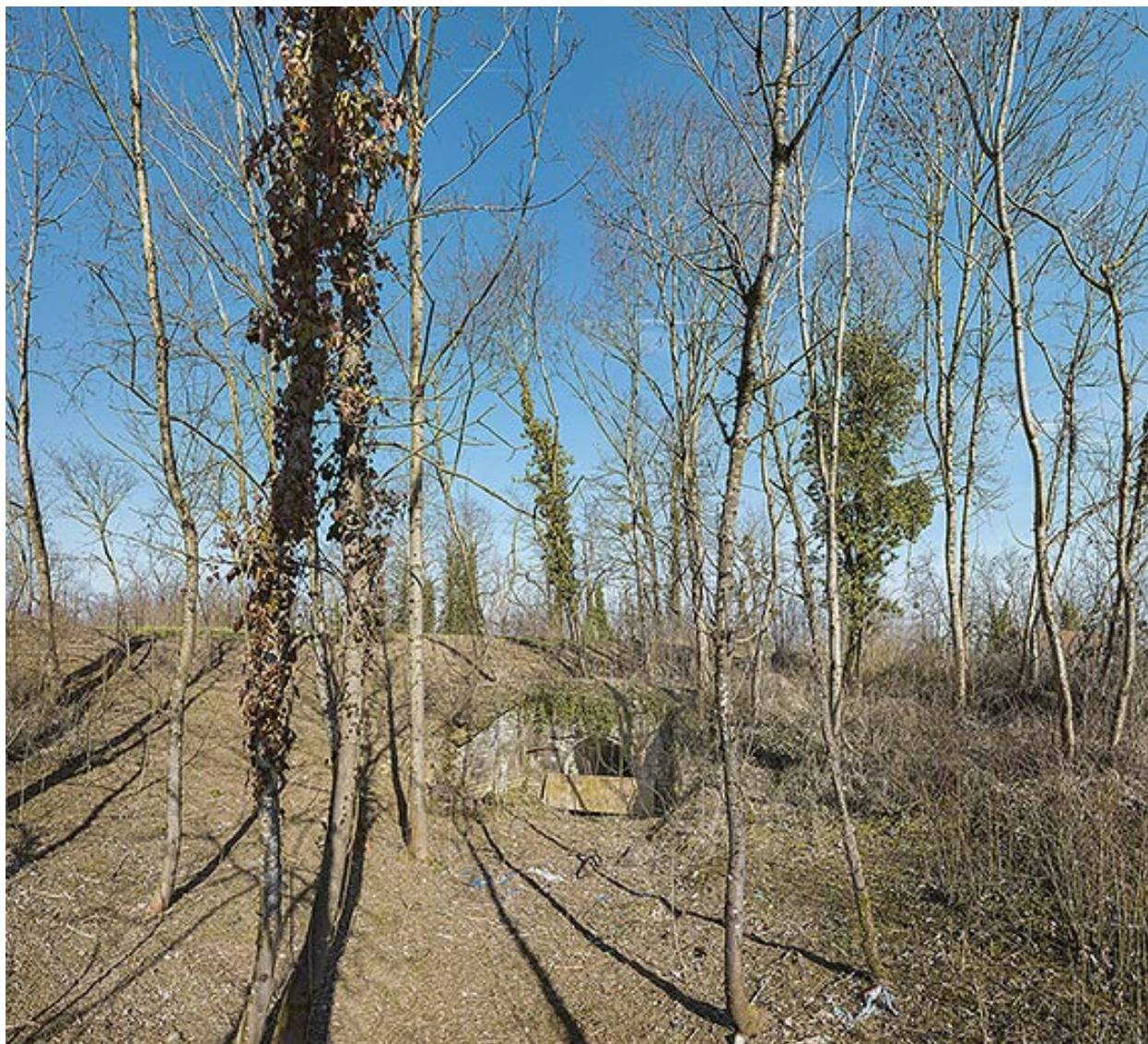
Traverse-abri envahie par la végétation.
