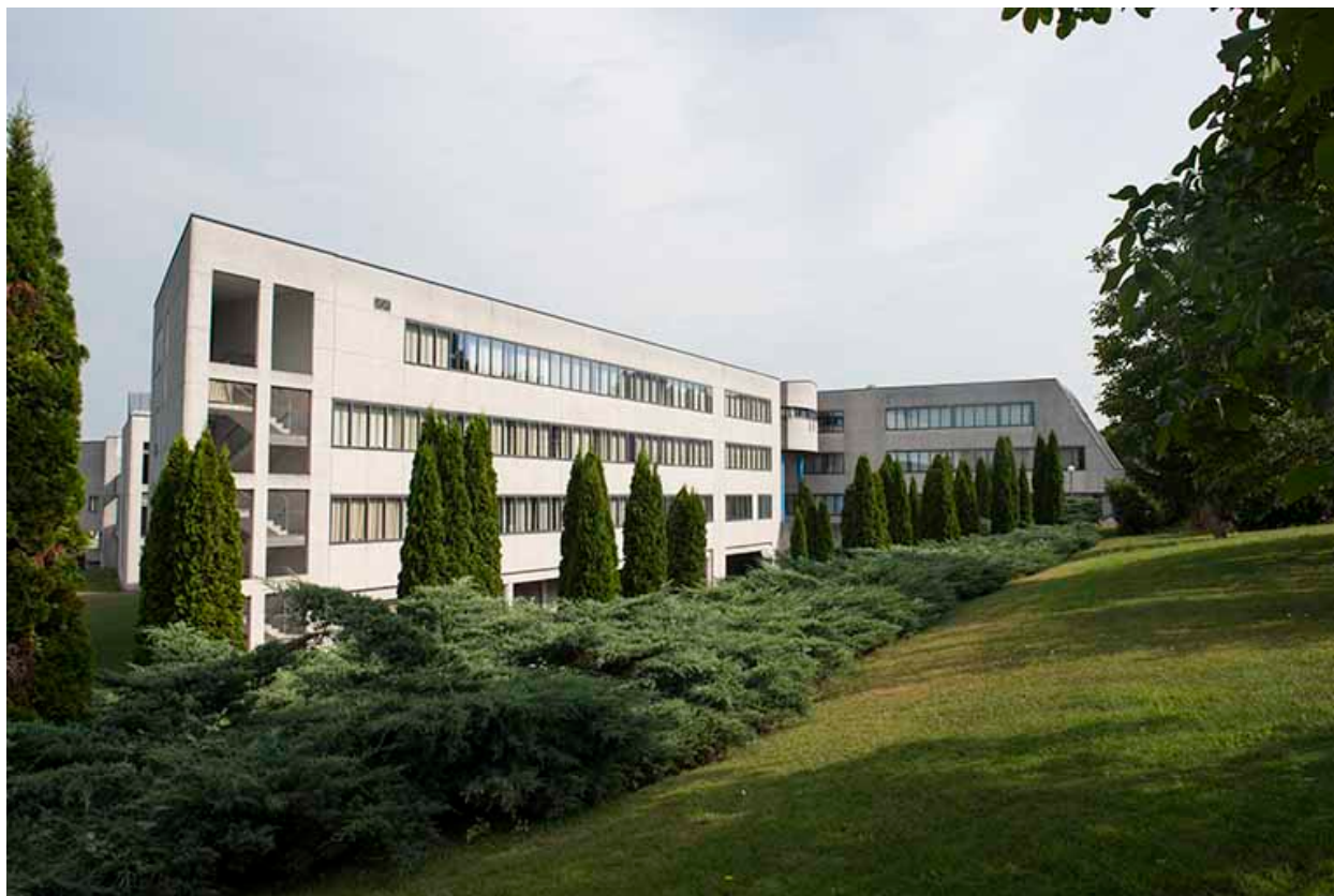
Angle sud, façade est, entrée postérieure.
