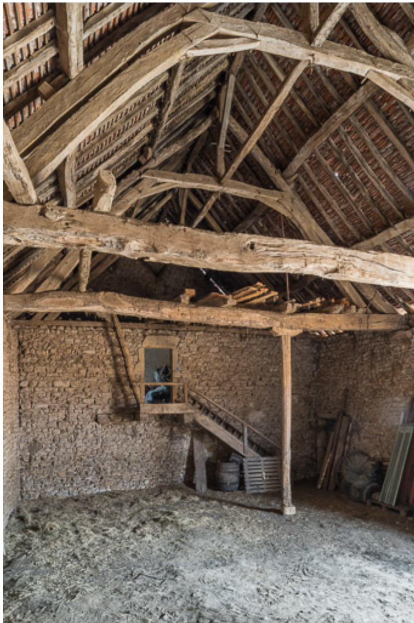
Vue intérieure du cuvage : escalier permettant l'accès à un grenier, situé dans le même bâtiment.
