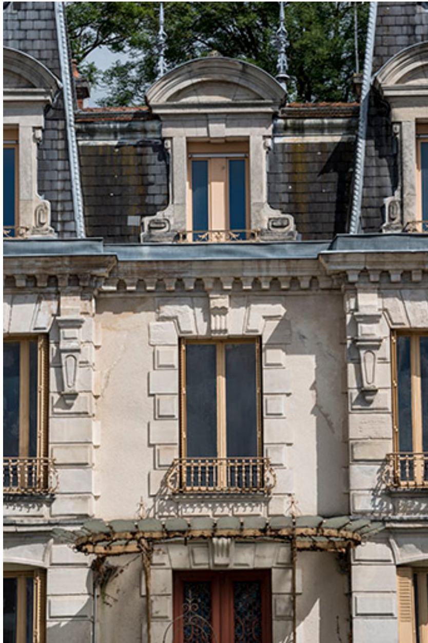
Détail de la travée centrale de la façade sud.
