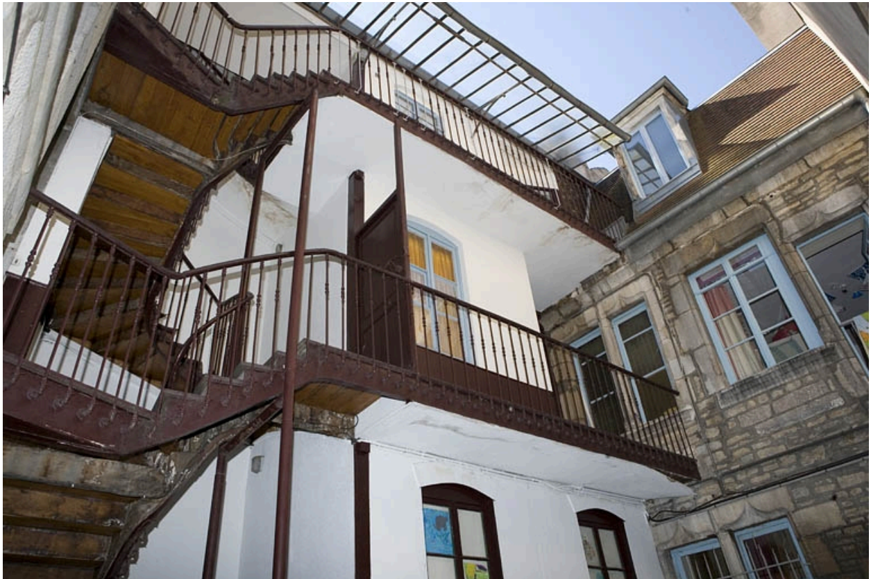
Détail de l'escalier à cage ouverte sur cour et de la façade postérieure du logis principal.
