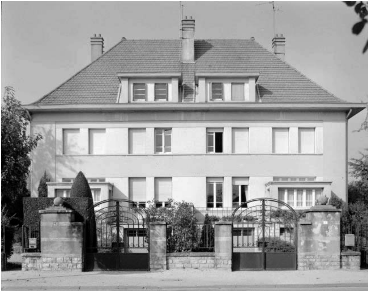
Maison identique, 5, 7 avenue Clémenceau.
