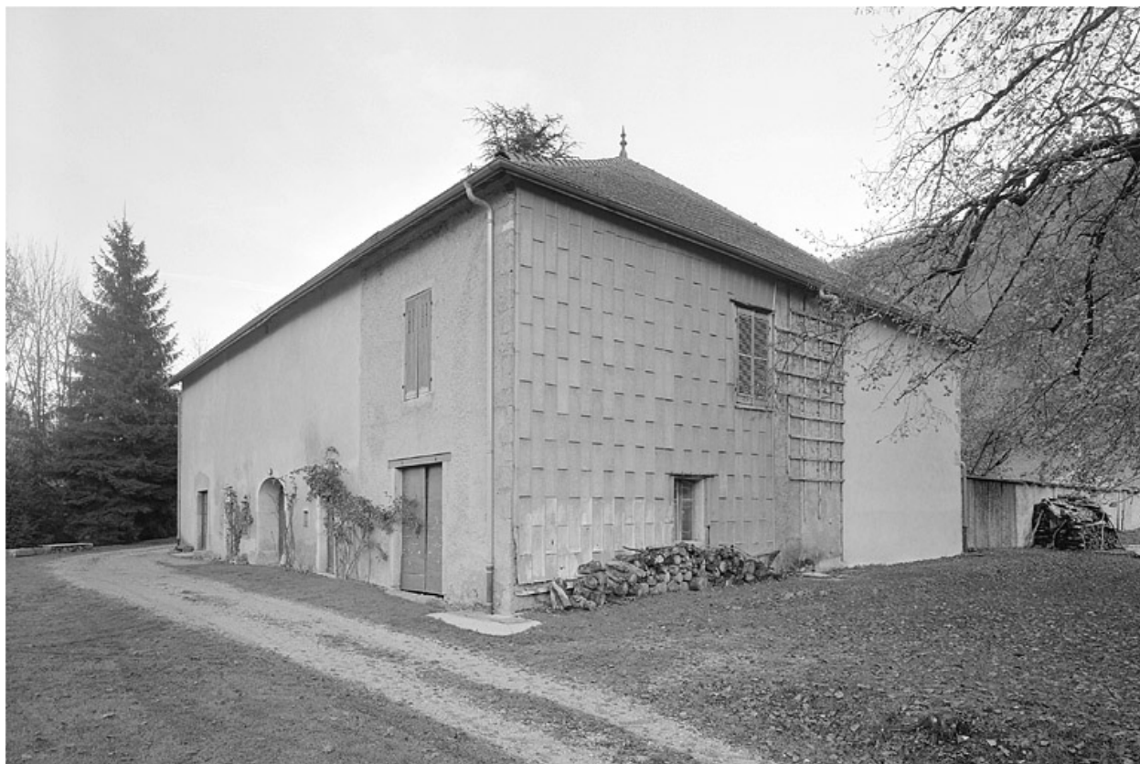
Face sud-ouest et façade postérieure.
