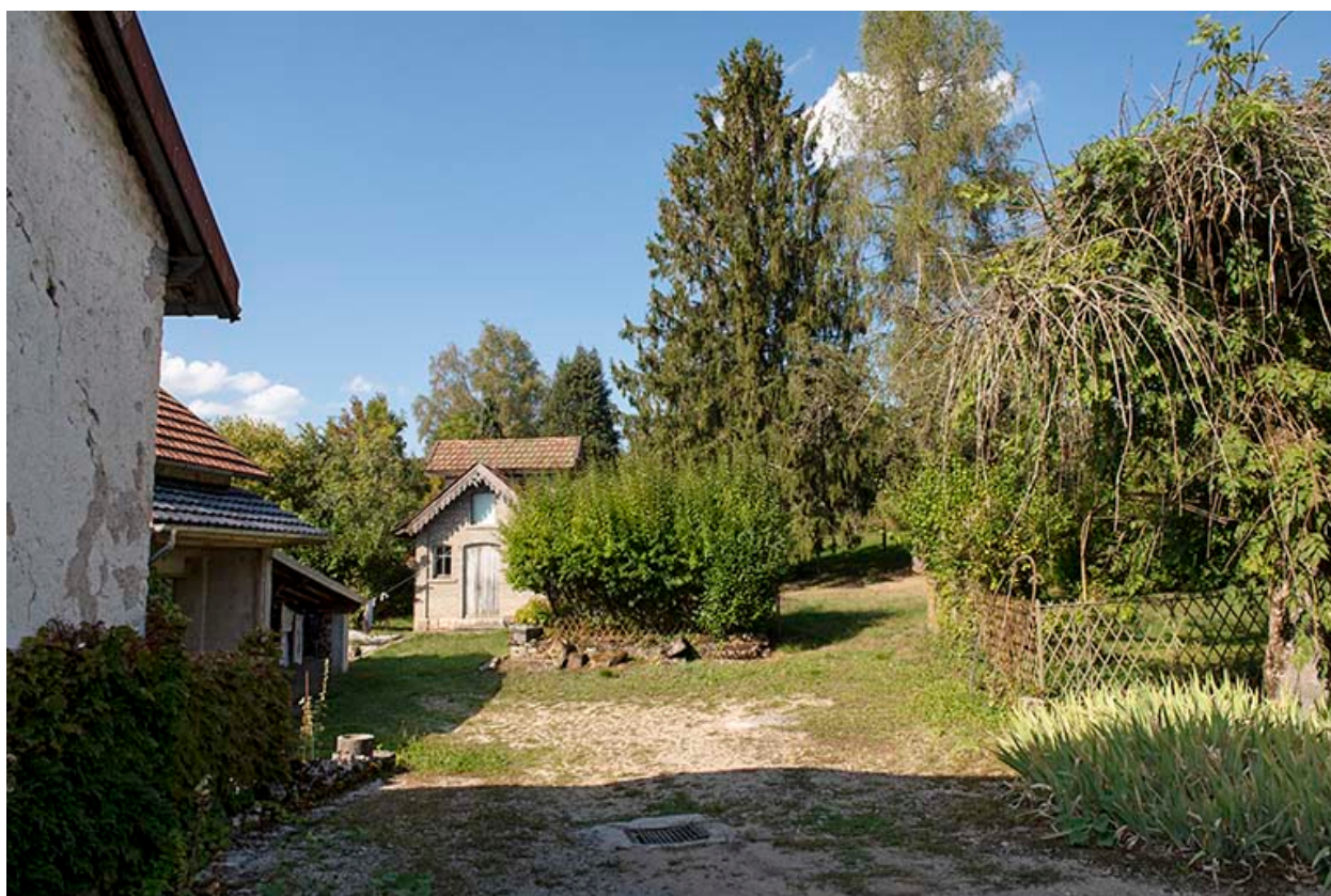
Vue d'ensemble du pigeonnier.
