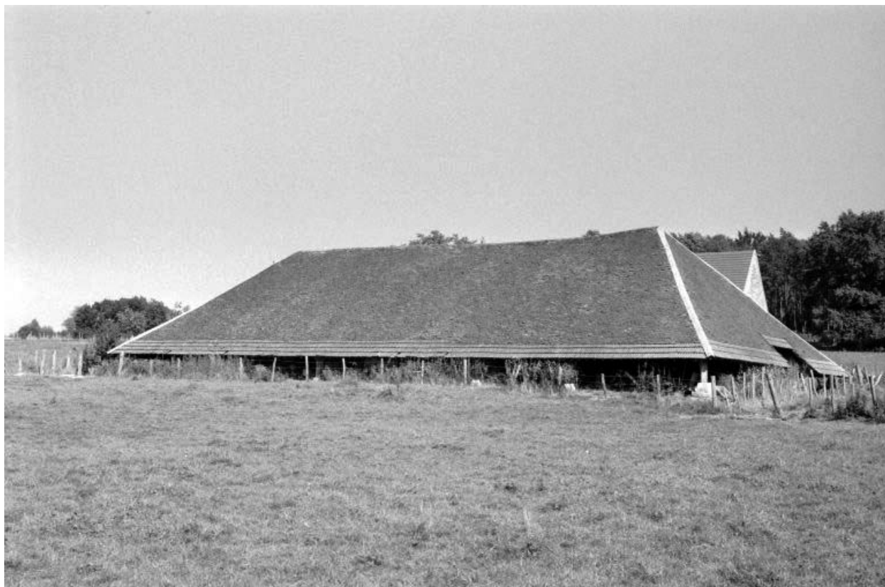
Halle de séchage, depuis l'ouest.
