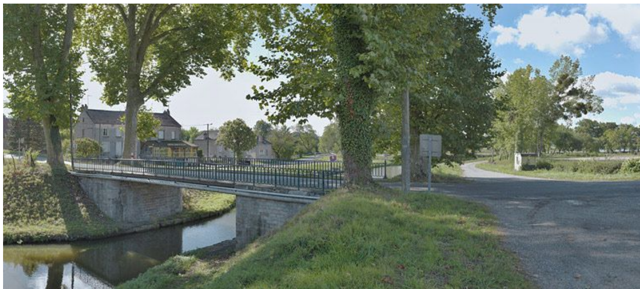
Le pont vu d'aval. Café en face.
