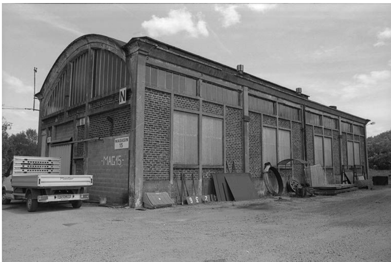
Ancien hangar des locomotives.
