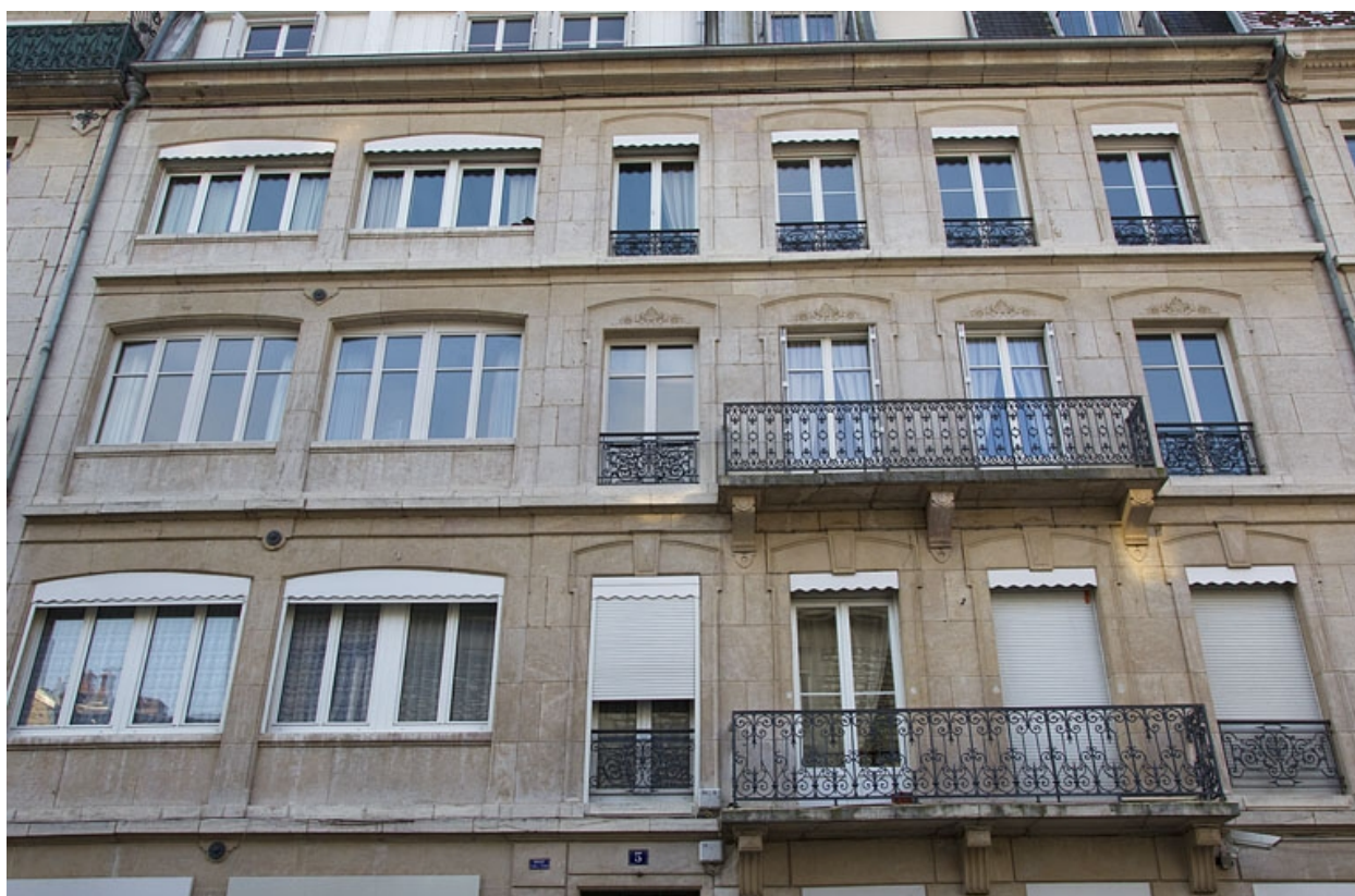
Vue d'ensemble de la façade, de face.
