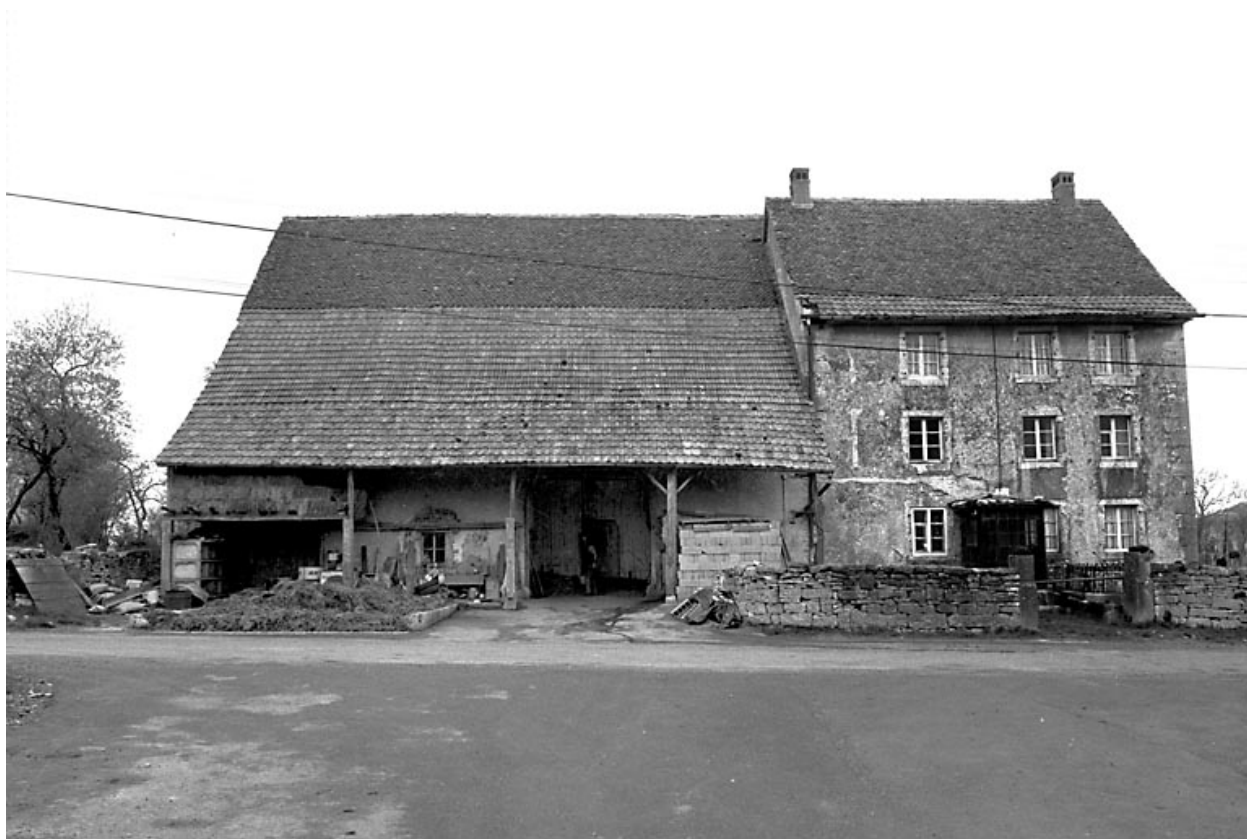
Croix : ferme située 33 rue Principale.
