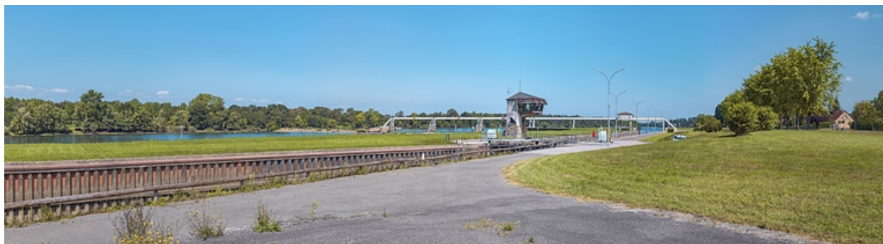
Tête aval de l'écluse.
