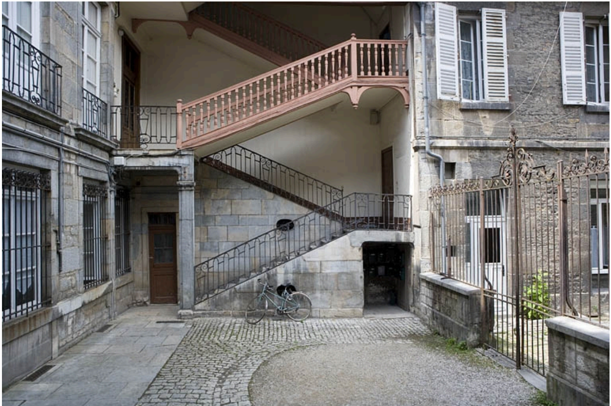
Vue de l'escalier à cage ouverte à gauche de la cour : de face.
