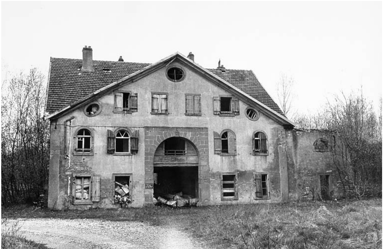
Bâtiment d'entrée ouest en 1977. Façade antérieure.
